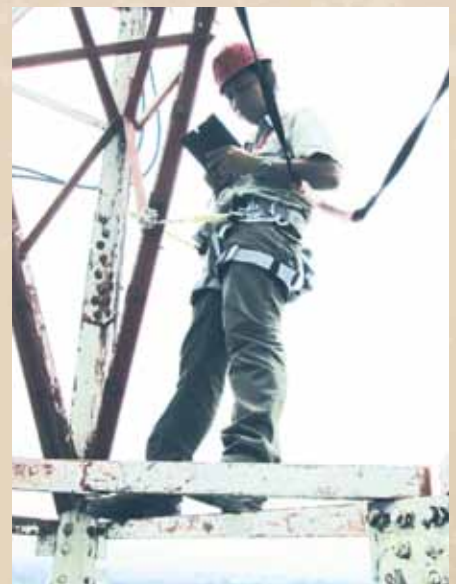
Pemeriksaan tower existing dengan menggunakan tools yang terintegrasi di smartphone (tarantula mobility).
